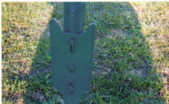
Bild 1: Ankerplatte am T-Pfosten zur Erhöhung der Standsicherheit
